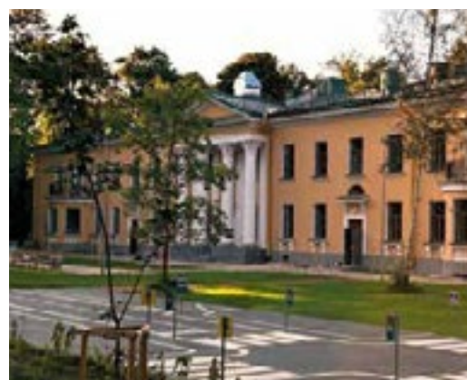
Детский сад № 123. Выборгский р-н, Новороссийская ул., 42. Произведён капремонт (80 мест).
