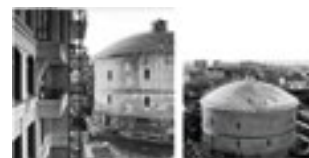
Газгольдер (Заозёрная ул., 3)
